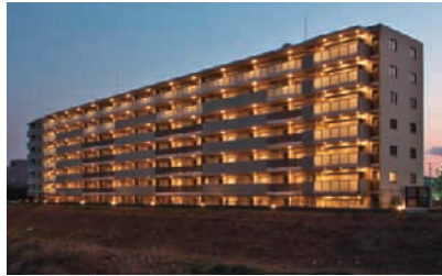
開放廊下LED照明
