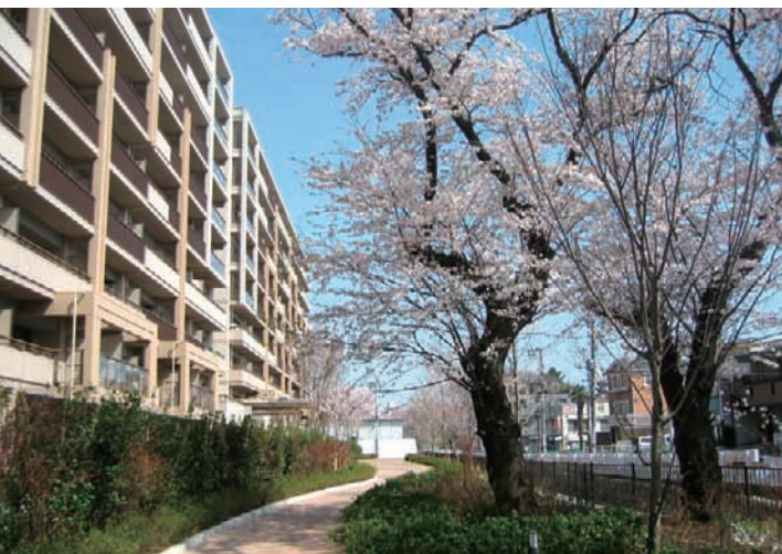
地域の景観を継承する仙川沿いの既存樹
