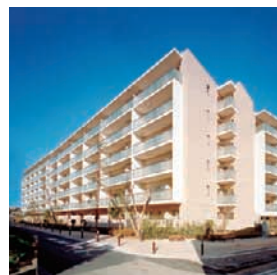
2000年 SI住宅「ハウスソラーナ」竣工
