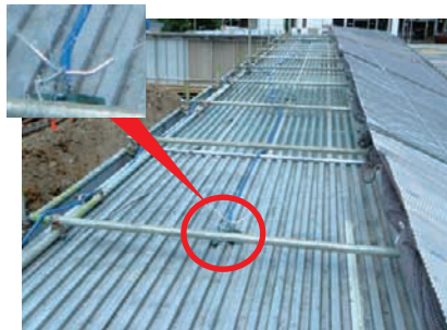
仮設事務所屋根に散水し、エアコンの稼働率を低減
