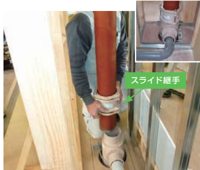
住戸内PS更新手順の検証状況
