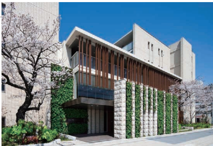
綱島街道側の壁面緑化と桜並木
