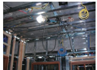
内装作業照明に蛍光灯を採用
