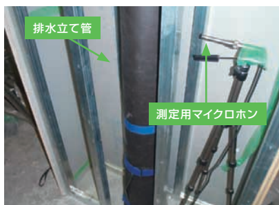
排水立て管の排水流下音実験風景
