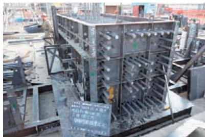
鋼製型枠組立状況
